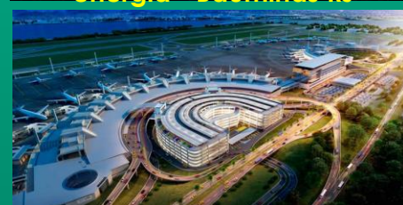
Preventiva Subestações de energia – Bauminas RJ
